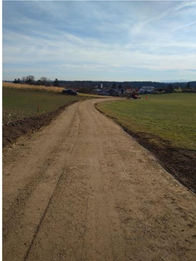
Fotos Straße Hintersberg
