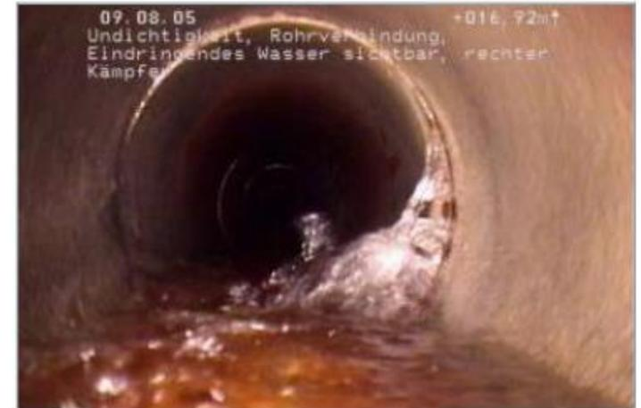
Abb. 4: Wenn aber Grundwasser in die Leitung eindringt, muss schnell gehandelt werden. Hier ist die Sanierungspriorität sehr hoch.
